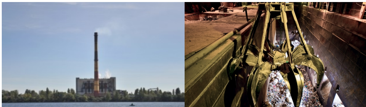
Рис. 12 – Зовнішній вигляд і завантажувальний кран ССЗ «Енергія»
