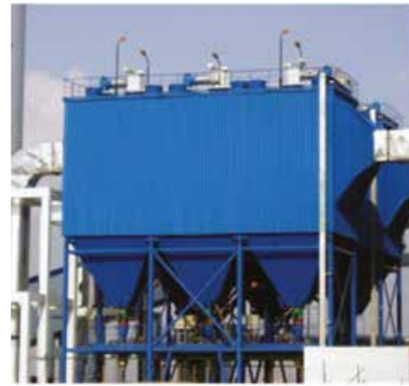
Рисунок 16 – Загальний вигляд системи газоочистки з електрофільтром
