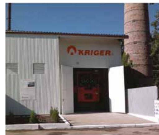
Рисунок 19 – Загальний вигляд котельні Житомирського обласного психоневрологічного відділення
