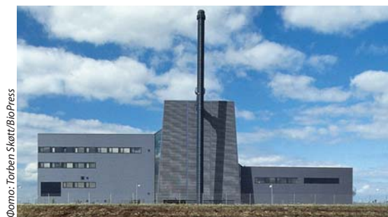
С 1980 г. в Дании происходит процесс децентрализации энергетической промышленности страны, и сегодня электричество и теплоэнергия вырабатываются на многочисленных небольших теплоцентралях.
