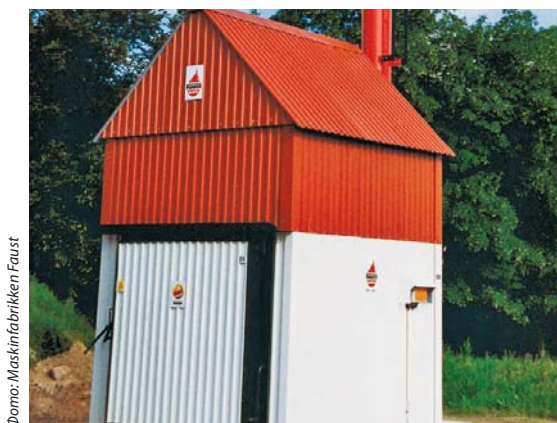
Порционные печные установки, как правило, располагаются в отдельном здании с целью минимизировать угрозу пожара для соседних построек.
