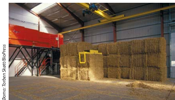
Соломохранилище на станции централизованного теплоснабжения Terndrup. Перемещение тюков соломы от хранилища к печному отделению осуществляется автоматическим краном. Площадь хранилища вмещает однонедельный запас соломы в зимний период.
